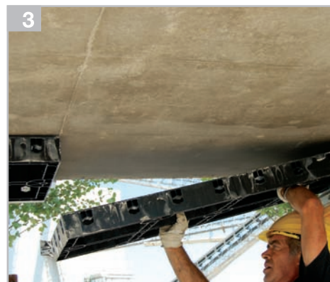
3 Wyszunąć panele spod betonowania
