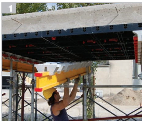
1 Zdjąć dźwigar w kształcie litery H
