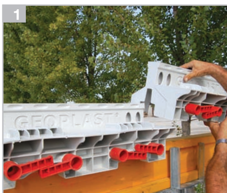
1 Ułożyć dźwigar Y połączony z klinem
