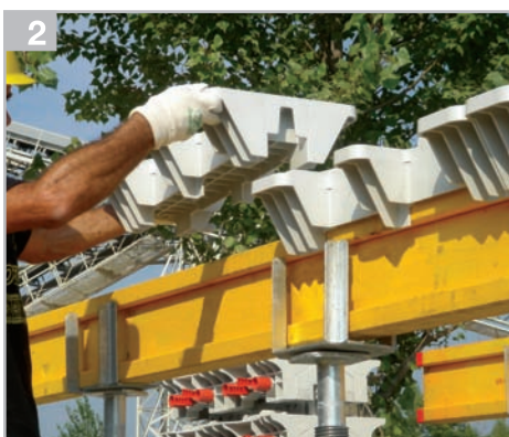
2 Ułożyć dźwigar w kształcie litery H
