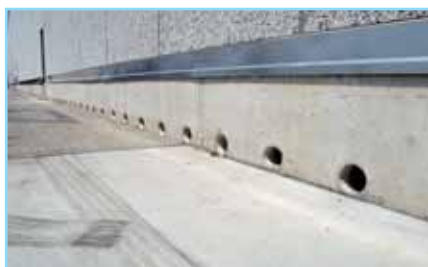
Rys. 5) Odpowiednia wentylacja zewnętrzna - Otwory średnio na każdy 1 m.
