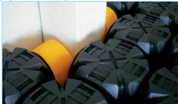
Rys. 9) Przykład wypełnienia wokół kolumn.
